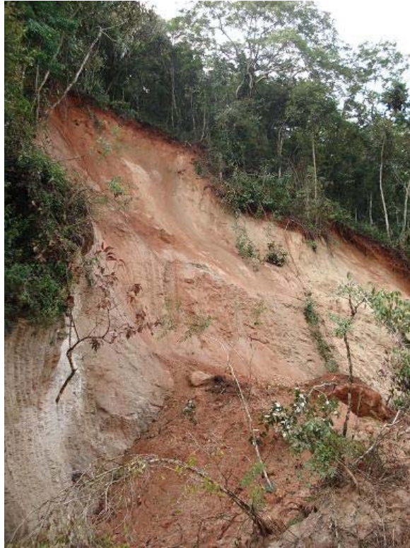
Figura 1. 2 – Deslizamento em um corte de estrada.
