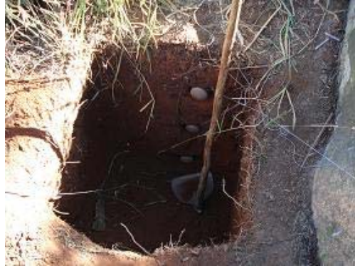
Figura 3. 40 – Abertura de trincheira para colocação dos tubos na posição horizontal.
