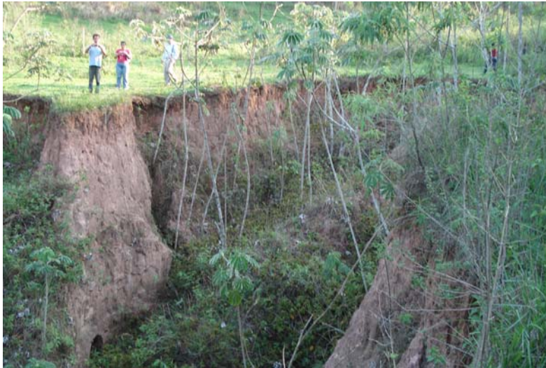
Figura 2. 5 - Erosão por voçorocamento (Bananal, SP).
