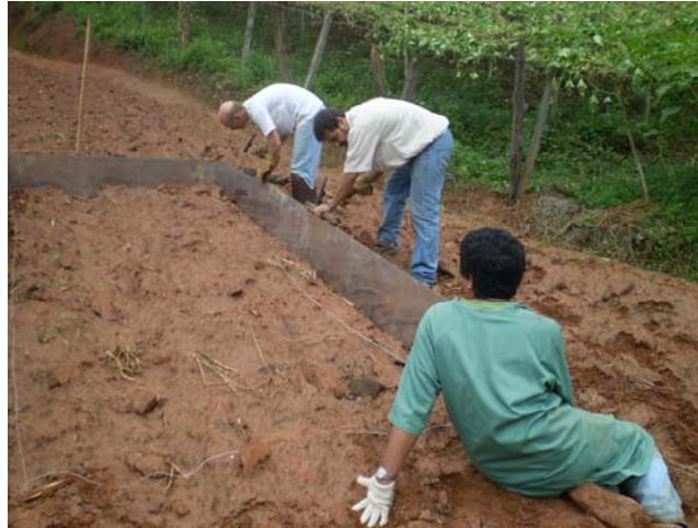
Figura 3. 12 – Folha de flandres sendo cravada no solo.
