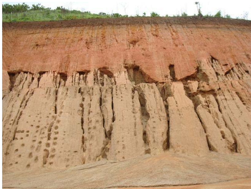
Figura 1. 3 – Corte com erosão para futura construção civil.
