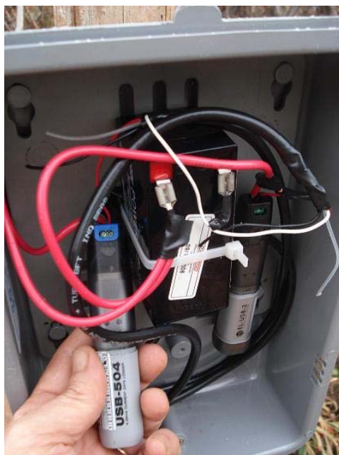
Figura 3. 36 – Data logger sendo retirado.
